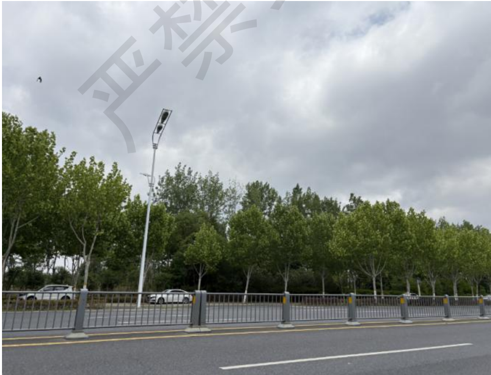
图2 建西侧新蚌埠路
