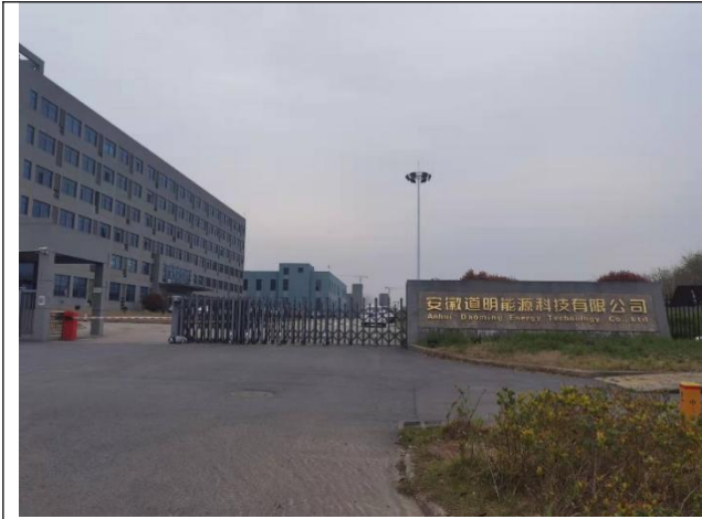
建东侧道明能源科技有限公司
