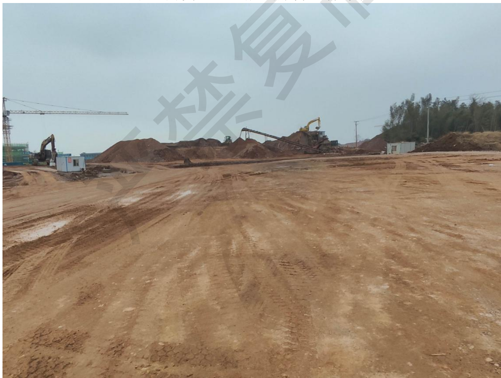
站区西侧天天高速（在建）
