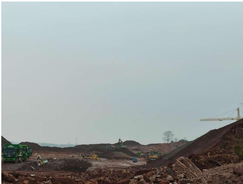
图 1.2 项目北侧空地
