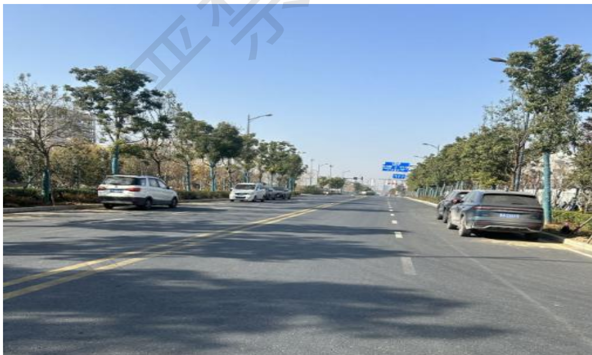
图 2.2-4 厂区南侧珠城西路
