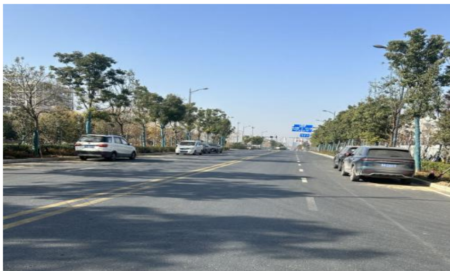
厂区南侧珠城西路
