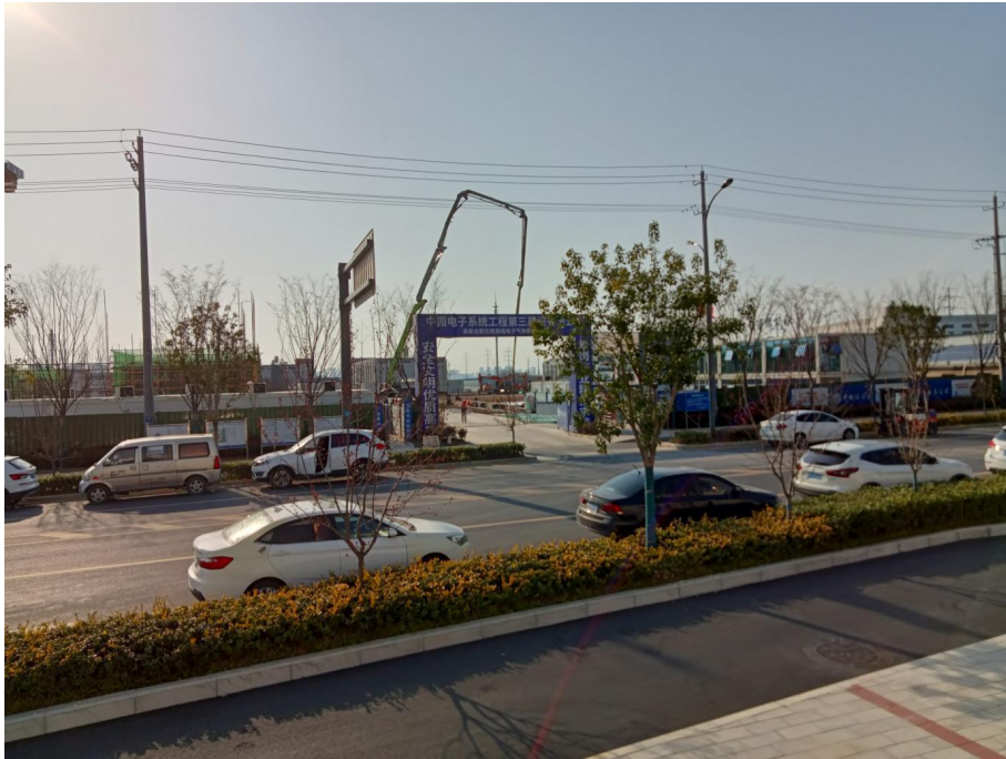
厂区西侧通宝路及合肥先微半导体材料有限公司（建设中）
