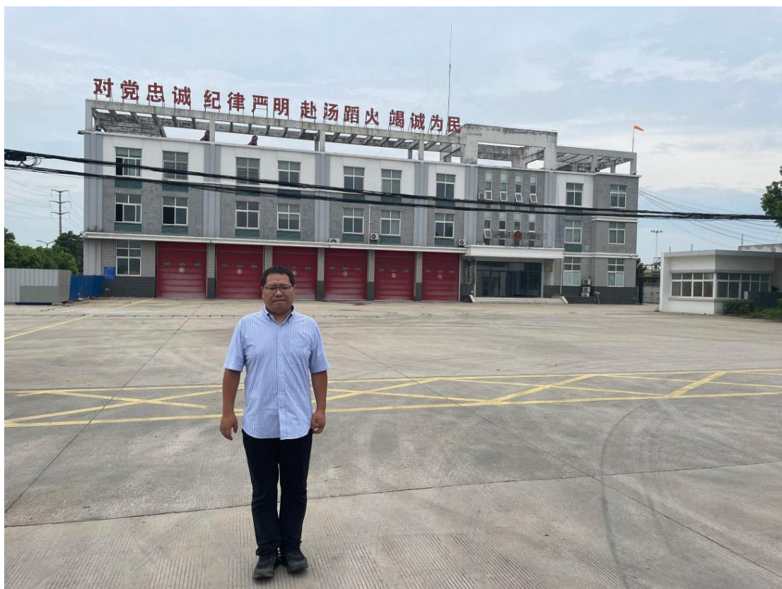
图 16 现场勘查照片 3
