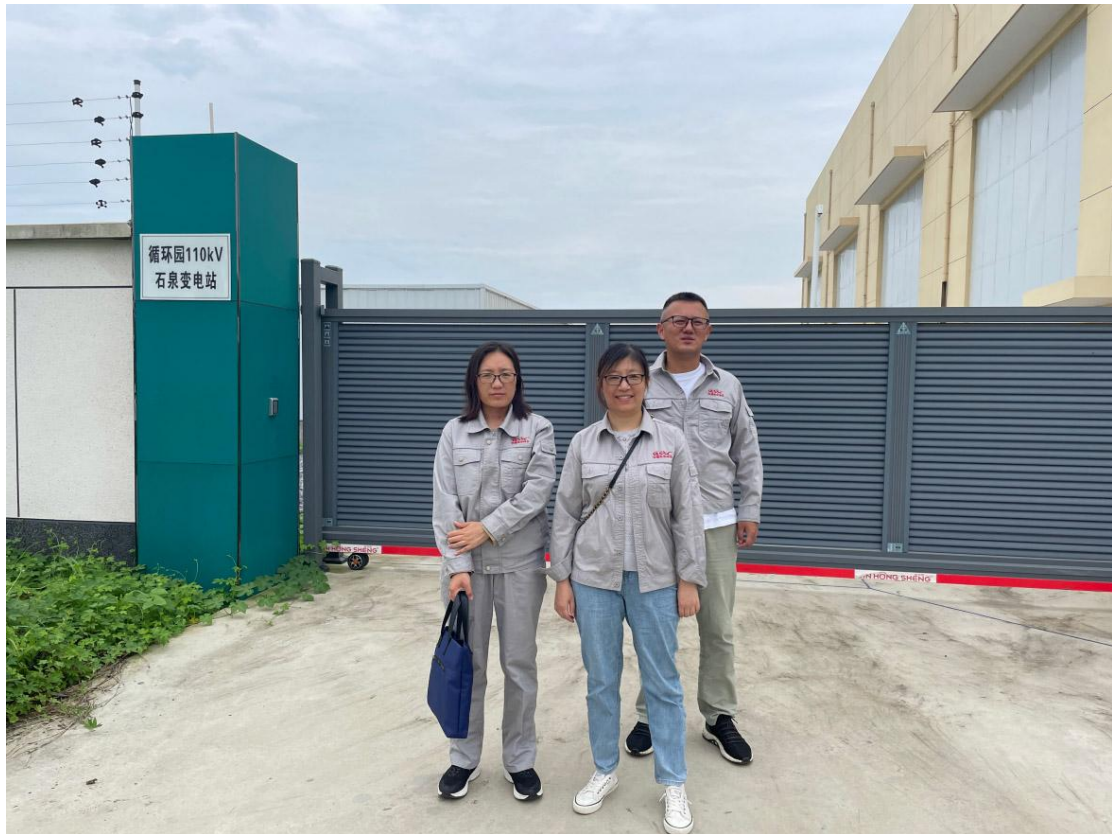
图 25 现场勘查照片 12
