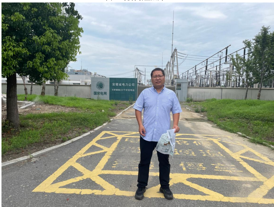
图 20 现场勘查照片 7
