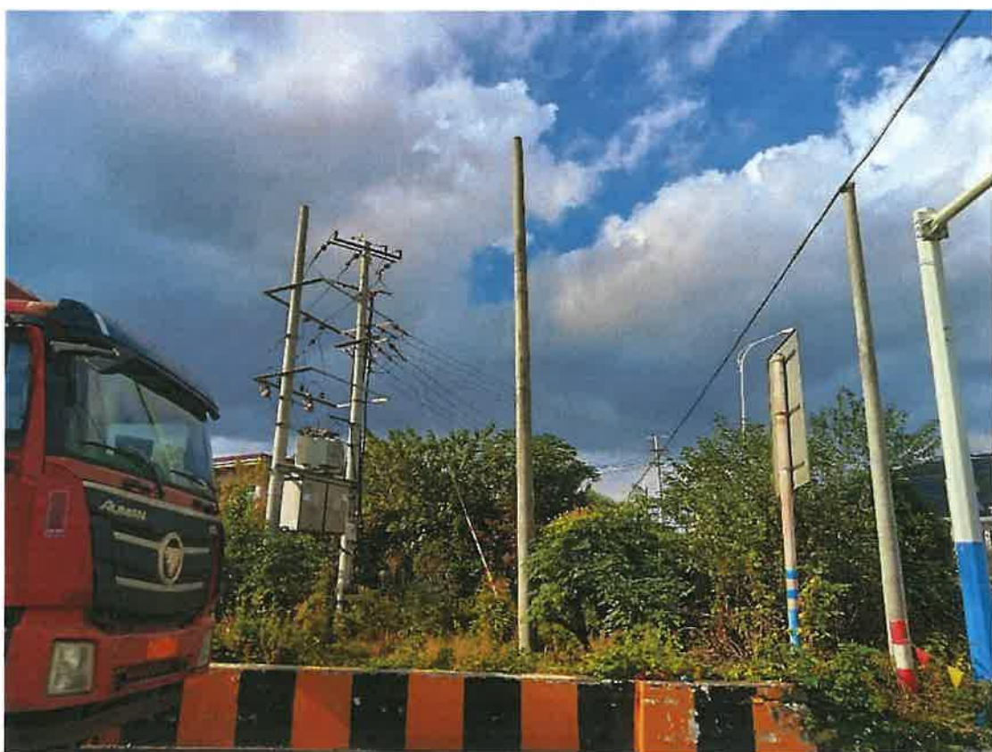
图6 项目北侧空地，有零星民居、一条架空电力线及室外变压器
