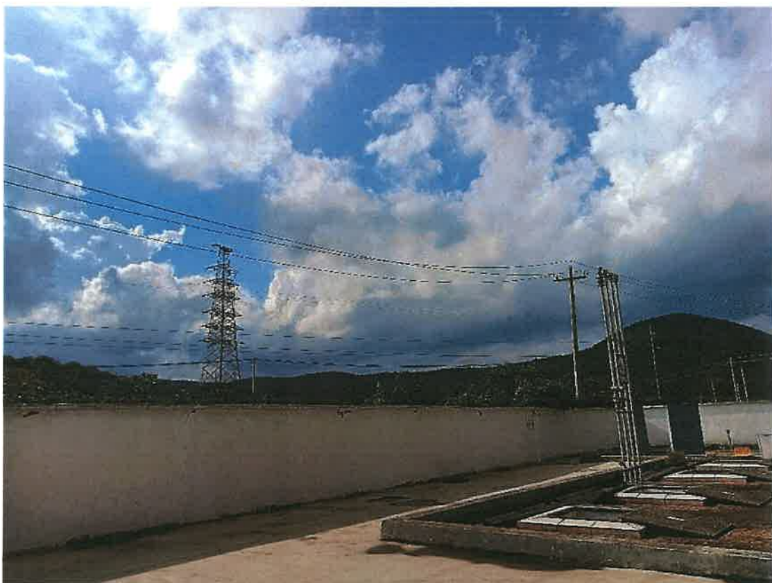
图5 项目西侧空地，有架空电力线
