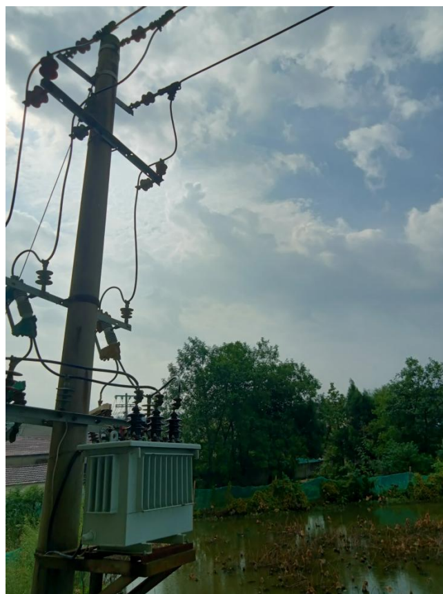
图3 西侧电力线路、池塘，站房东南侧围墙外设有一变压器
