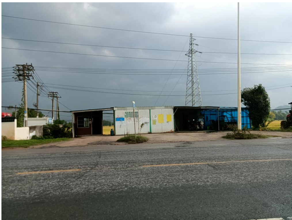
图1 东侧S216省道、S216省道路旁到站区罩棚之间有一条电力线路、S216省道东侧为临时板房（放液化气瓶）、电力线路
