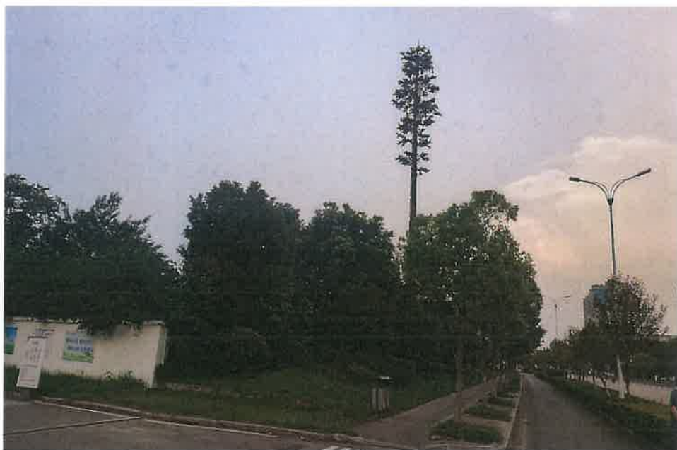
图 7 项目东南侧通信塔
