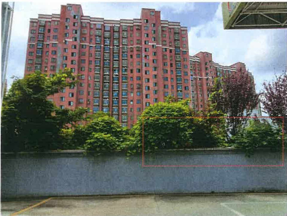
图 6 项目南侧都市新苑居民楼
