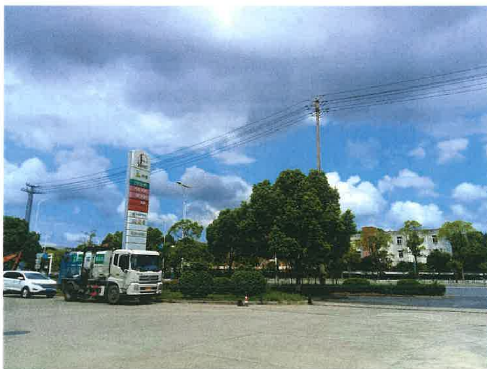
图 8 项目北侧世纪大道和架空电力线路
