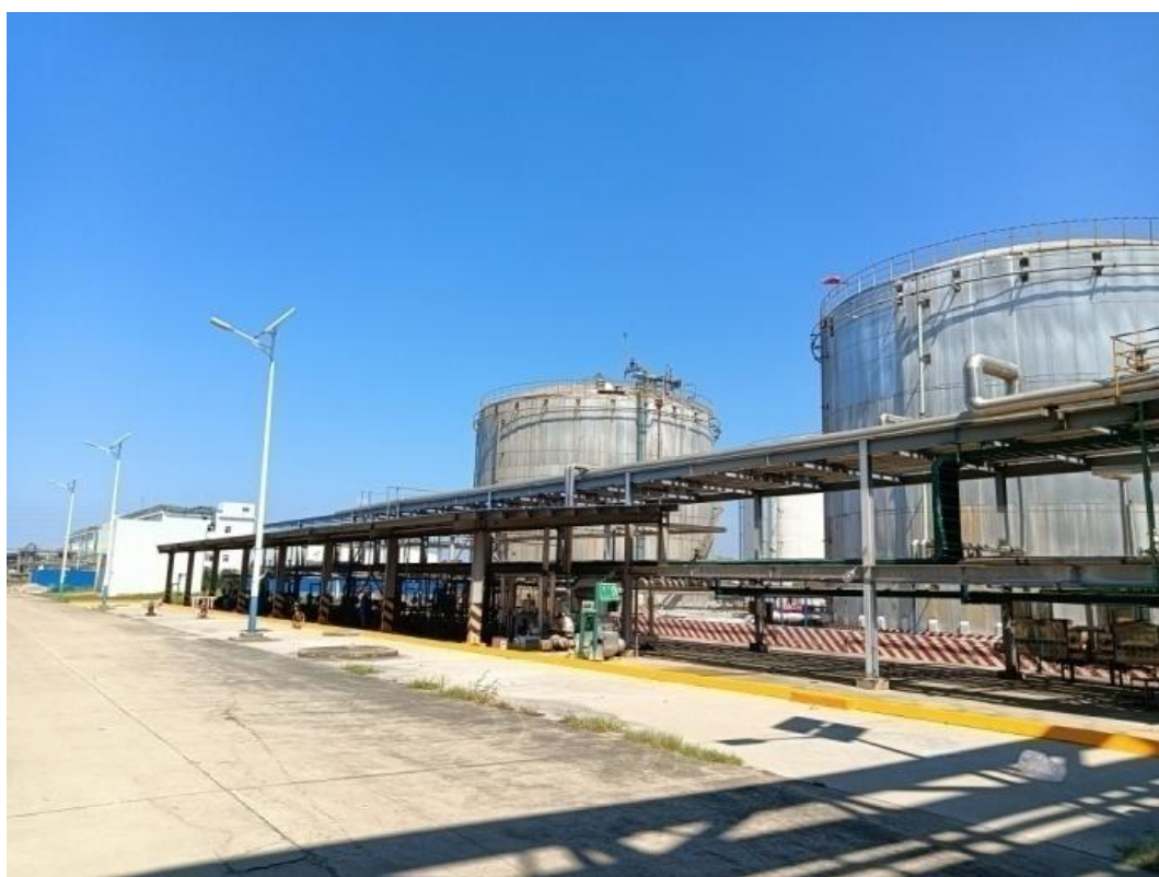
图 4 本项目北侧 DMO 中间罐区及泵区
