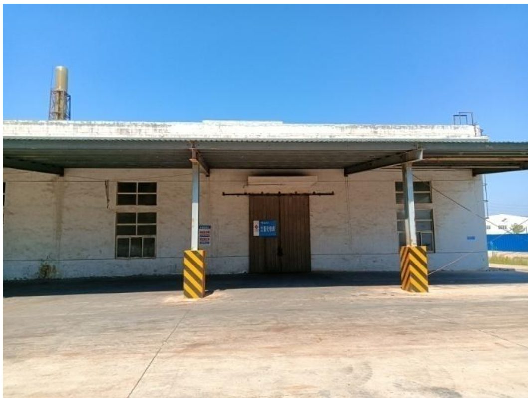
图 3 本项目西侧三氯化铁周转库
