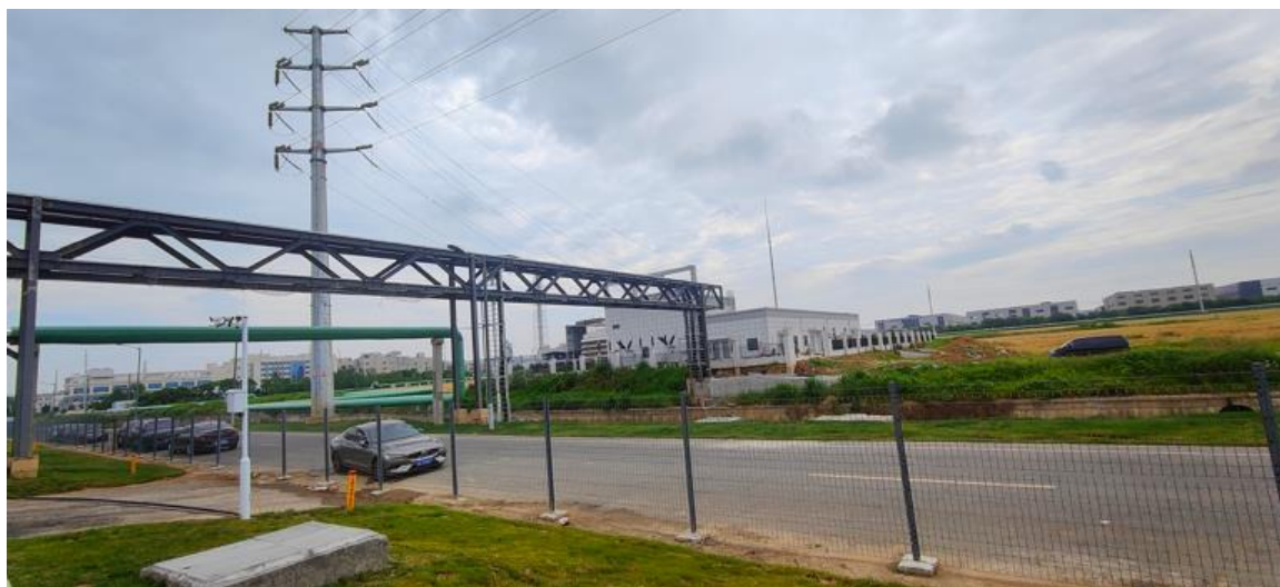
厂区东侧 110KV 变电站
