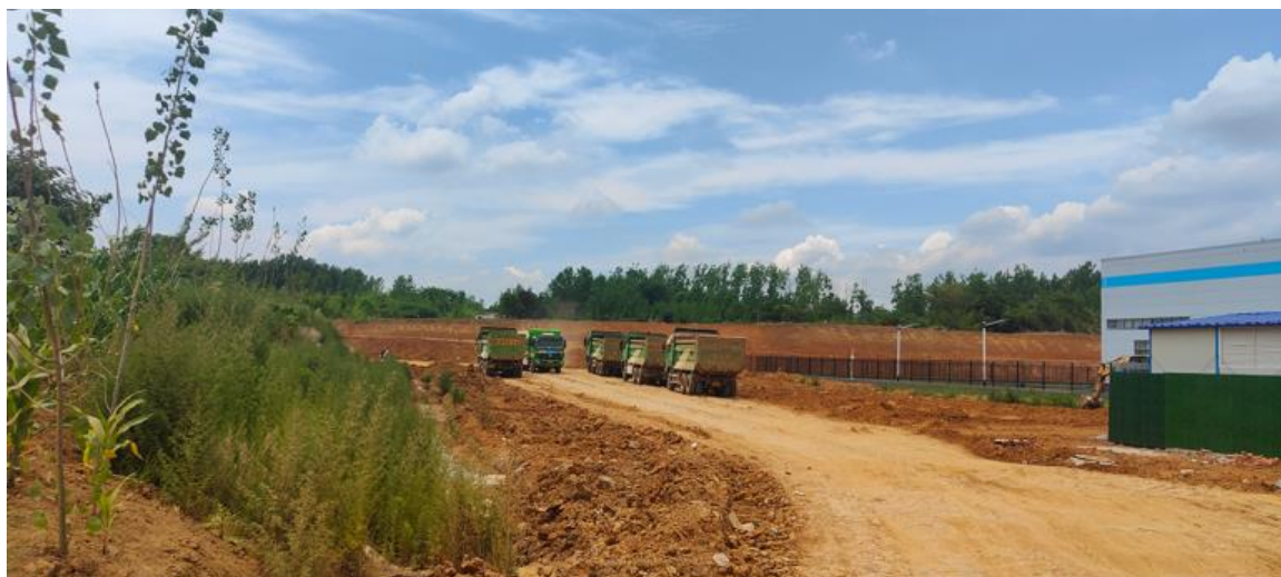
厂区西侧空地
