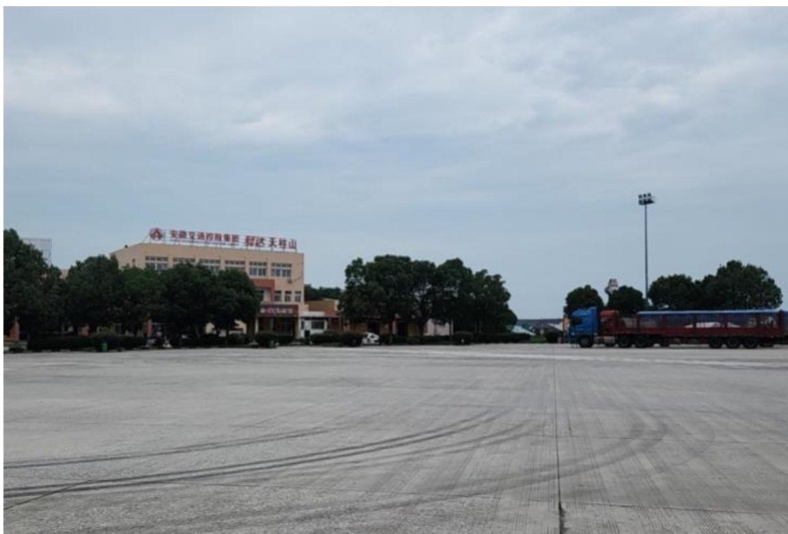
北侧大型车停车位、服务区综合楼。
