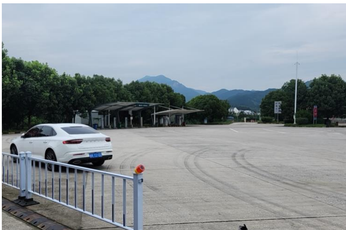
北侧充电桩（站外设施）
