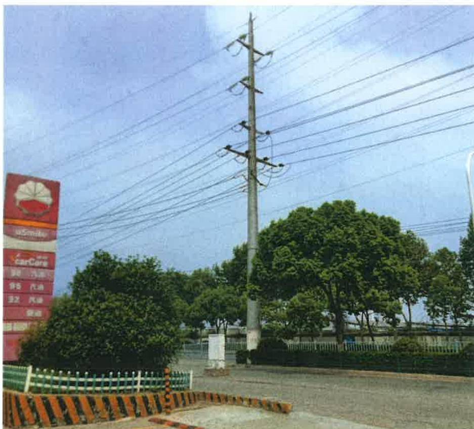
图 3 项目东侧长江北路和架空电力线路
