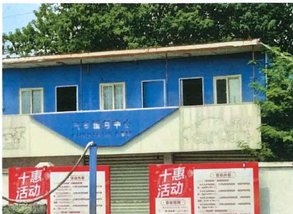
图 6 项目北侧二层闲置板房
