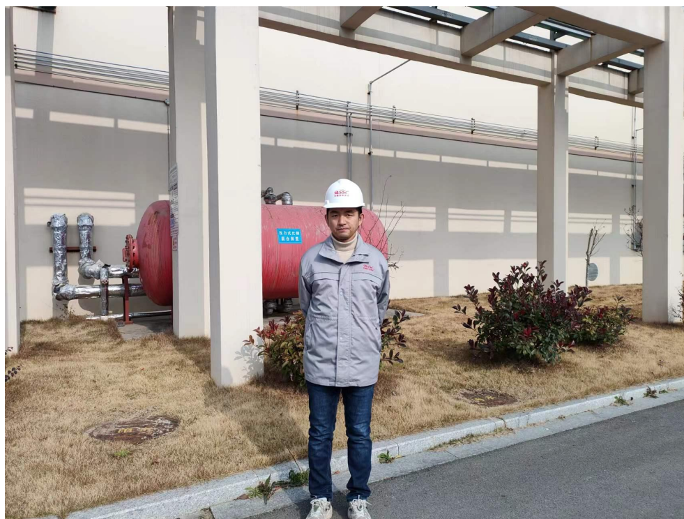
现场勘查照片 4
