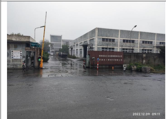
建西侧原镇海石化工贸公司下属的编织袋厂（宁波太一新材料有限公司），准备拆除中
