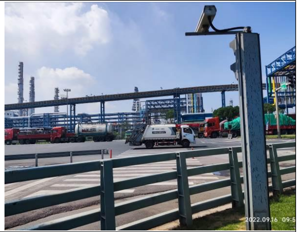
1#地块建西侧海天路、镇海炼化分公司 13#门岗
