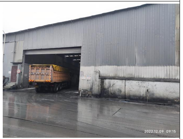
建西侧镇海炼化灰渣转运场
