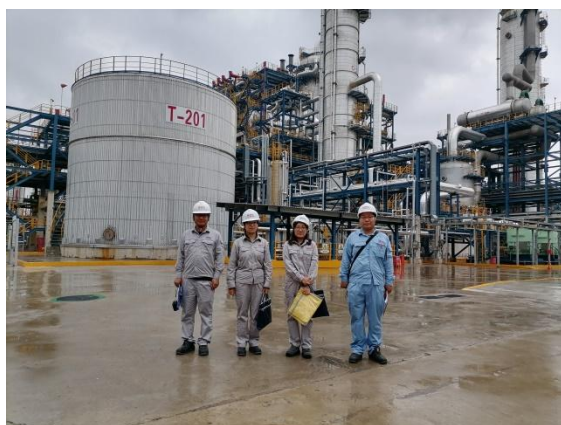
项目组（乙二醇装置 2022.8.29）
