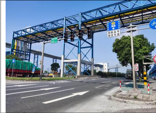
1#地块建西侧海天路
