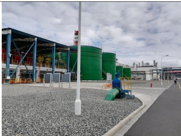
化水、凝结水处理站
