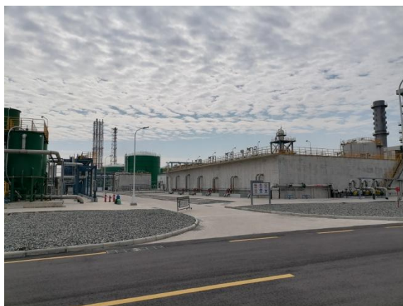
雨水监控及事故池及污水处理场
