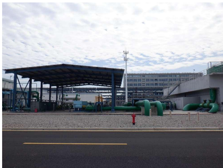
图 8 PO/SM 装置南侧扩建项目净化水场
